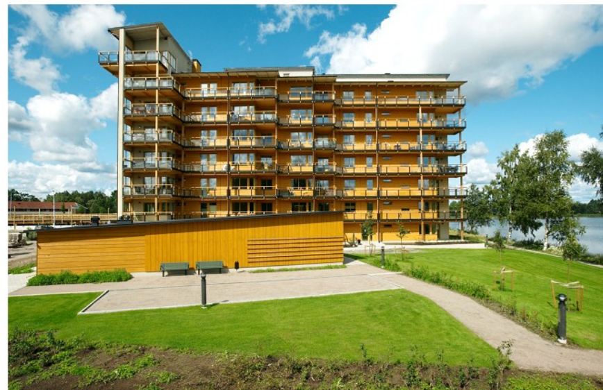
Immeuble bois 7 étages en panneaux massifs — Limnologen à Växjö
